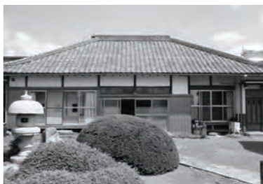
改修前の写真
