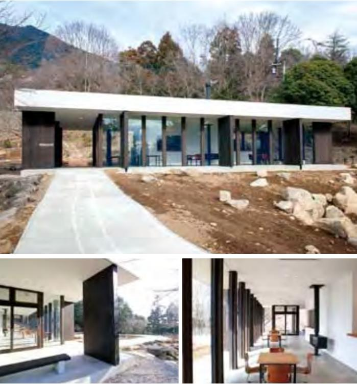
構造は在来木造ですが、耐力壁を外周に井桁状に配置することで、室内と室外を隔てる壁を取り払いました。林の中を散策して通り抜けられるような感覚で、2方向からアクセスできます。
