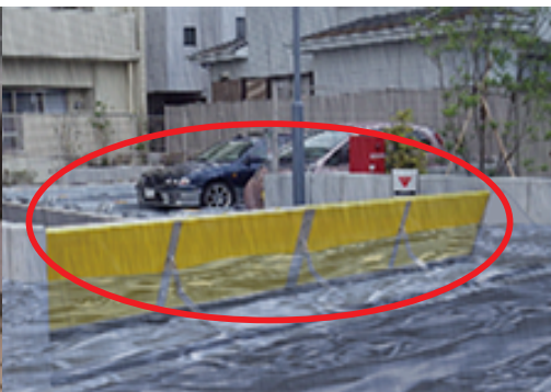
●浮力起伏式の止水板
