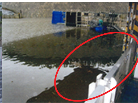
●2017年7月豪雨に際し、水を堰止める止水板
