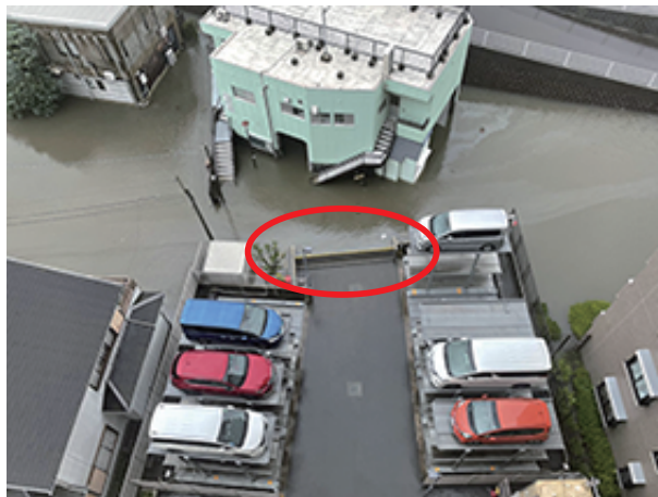
●周囲が浸水する中、止水板で浸水を防いだ駐車場
